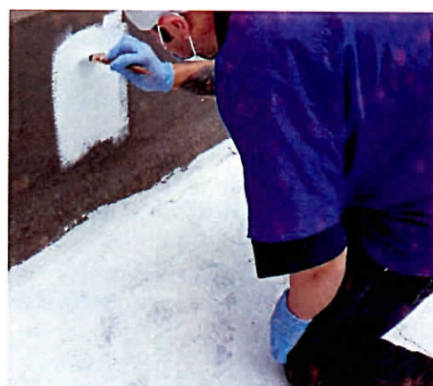
Fig. 4. APLICACIÓN DE LA PINTURA EN DUROCK
