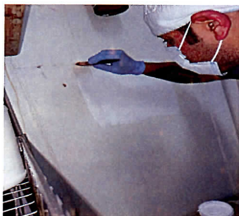
Fig. 3. APLICACIÓN DE LA PINTURA EN TABLA ROCA
